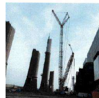
Démolition mécanique de la cheminée tranche 3
