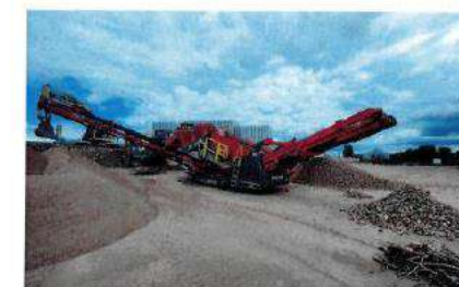
Criblage des gravats issus de la cheminée tranche 3
